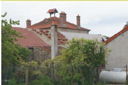
Il était nécessaire de refaire la toiture endommagée de l'école et du préau. Les travaux qui se sont étalés du 22 au 30 avril ont été effectués avec soin et propreté par une entreprise locale. Une bâche au dessous des tuiles a également été posée pour protéger des infiltrations de neige entre autre.
