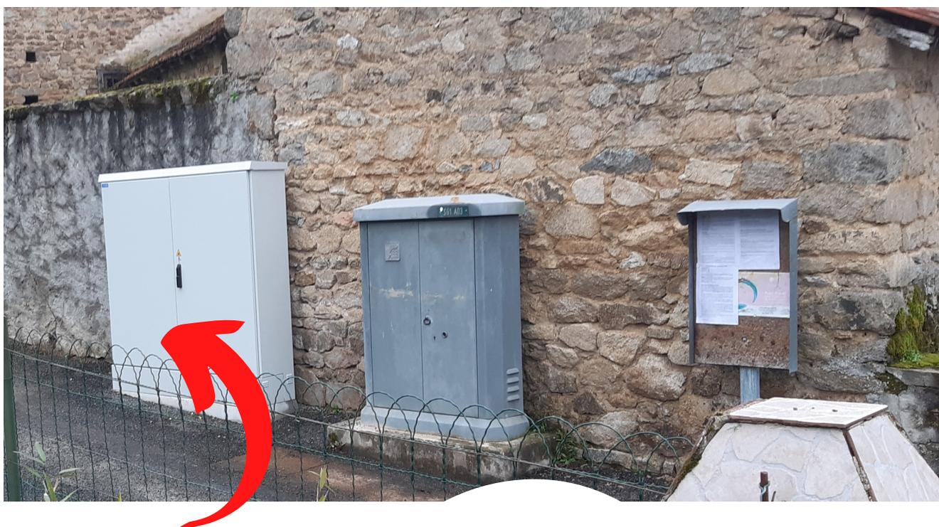
3 armoires PMZ (Point de Mutualisation de Zone) ont été posées dans notre commune, c'est l'endroit où sont connectés, par soudure ou brassage, les fibres optiques des différents opérateurs et les fibres optiques des utilisateurs.
